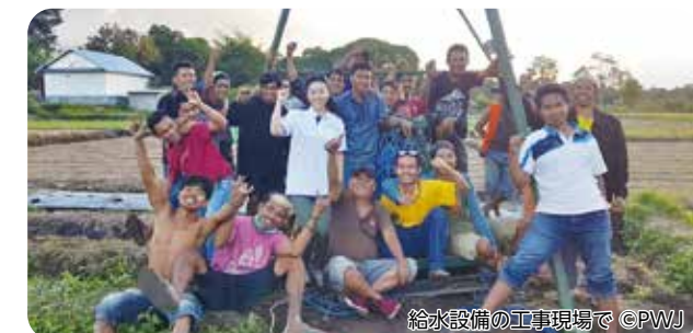
給水設備の工事現場で ©PWJ
